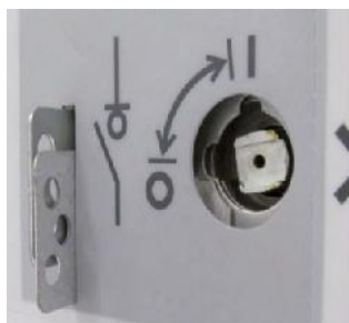
شکل ۷-۶- نمونه‌ای از به کارگیری ابزارهای قفل کننده جهت پیاده سازی اینترلاک در تابلو فشار متوسط
